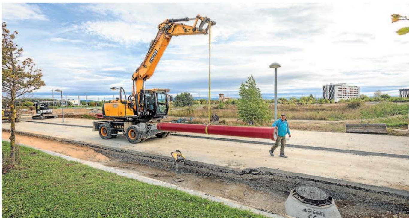
Trabajos en curso de renovación de tuberías en la salida de Vitoria por Salburua, junto a la rotonda que conecta la Avenida de Bruselas con la N-104. IGOR MARTÍN
